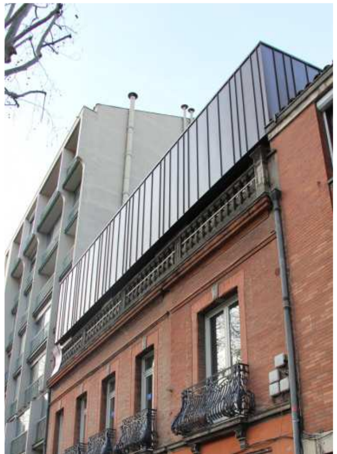
Immeuble rénové avec Bardage à joint debout en PIGMENTO couleur Brun Ecorce sur support ossature bois
