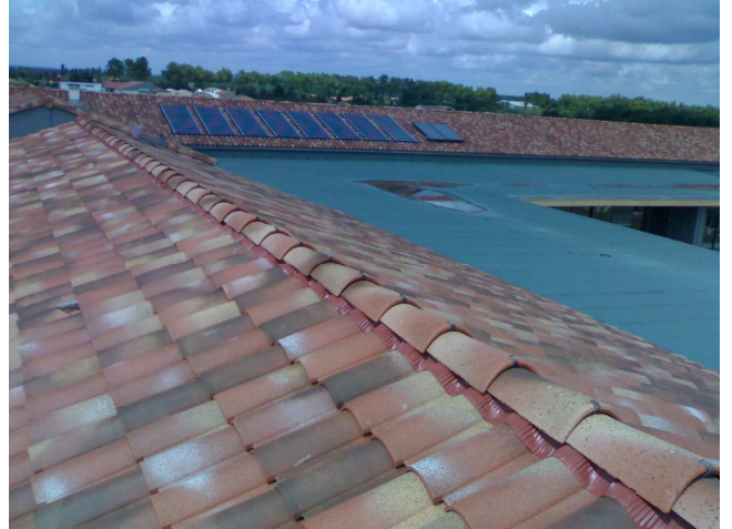
Pose de la couverture en tuiles avec intégration panneaux solaire
