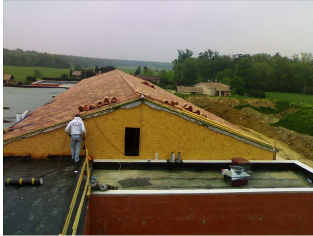
Installation et organisation du chantier
